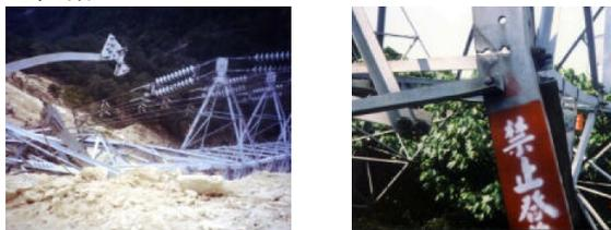
图 1 集集地震中输电塔-线体系破坏图
