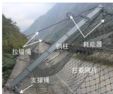
图1 柔性拦截结构的构成
