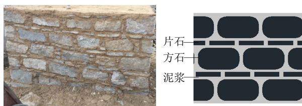
图2 藏式石砌墙体细部照片及平面内分布简化示意图
