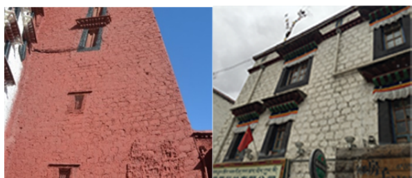
图1 典型的藏式石砌墙体
