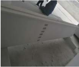
图 5 蒸压加气混凝土板开槽
