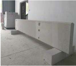
图 5 蒸压加气混凝土板开槽
