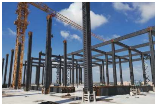
图 1 横肋波纹钢板-方钢管混凝土组合柱的工程应用 Fig. 1 Practical application of CFHCSPTC columns
