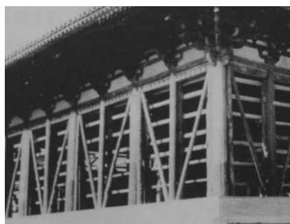
图 1 山西朔州崇福寺弥陀殿加斜撑提高墙体抗侧移刚度
