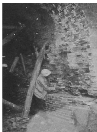
北门瓮城里门洞维修现场
