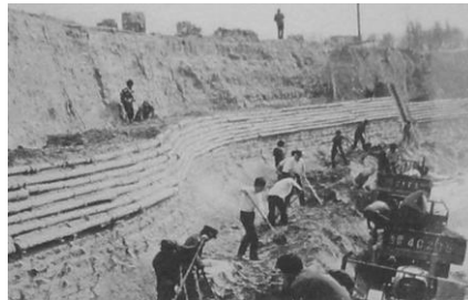
北墙内侧夯土维修
